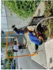
การสูบลบตะกอนจากบ่อกักไขมันของระบบบำบัดน้ำเสีย
